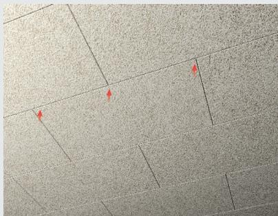
**E:** Die Revisionsklappe kann durch leichten Druck auf die Troldekt-Platte unter den Verriegelungen geöffnet werden.
