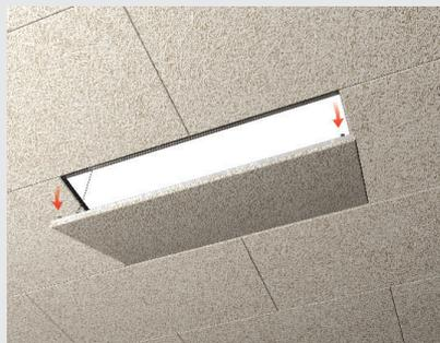
**F:** Durch Aushaken des Karabinerhakens kann die Revisionsklappe ganz geöffnet werden.
