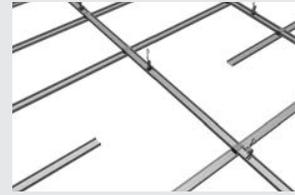
**1:** Das C60-Schienensystem montieren. Gehen Sie nach der Montageanleitung für Troldtekt-Akustikplatten an einem C60-Schienensystem vor. Die C60-Schiene in Armaturenlänge abtrennen.
