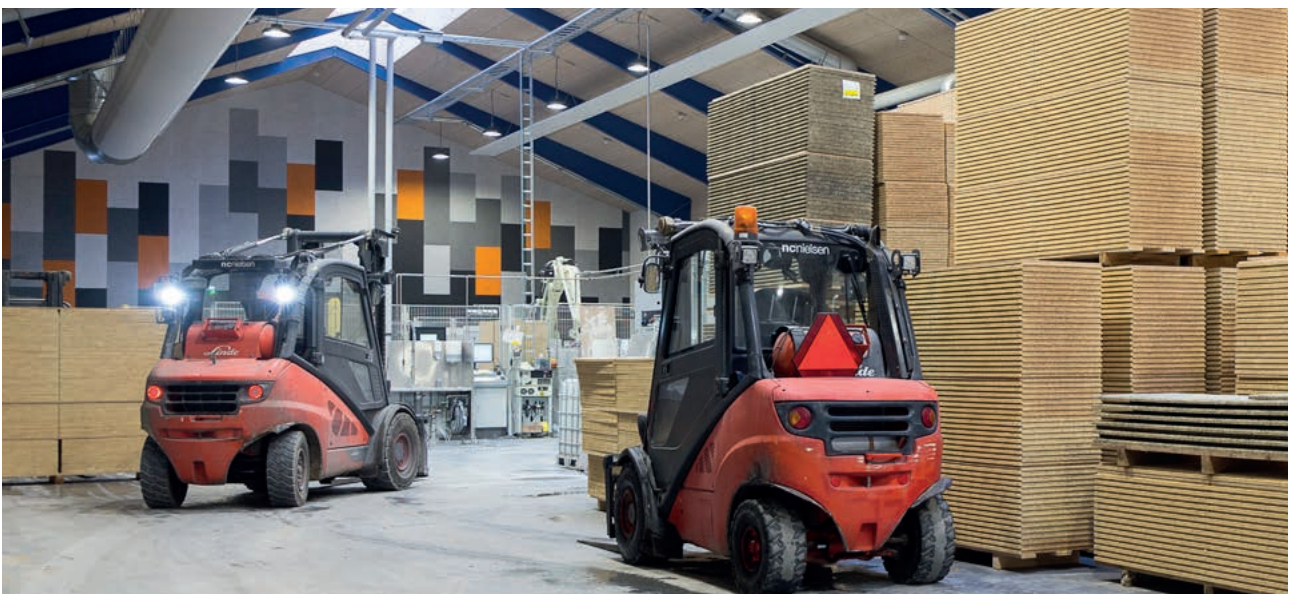
▲ Die Nachfrage nach Platten mit Farbanstrich steigt. Die neue Farbanlage arbeitet effizienter und erzeugt weniger Farbabfälle.
