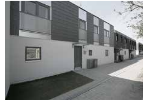
BO-VEST prøvehus er etablerer før helhedsplan for renovering af rækkehusene i Albertslund Syd. Der omlægges til lavtemperatur-fjernvarme i hele området.
