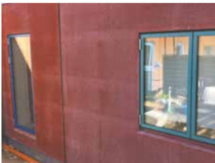
Xframe vindue i facade med u-værdi 0,78 W/m 2 K
