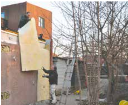
Sensorer på eksisterende facade og forberedelse til montering af nyt facadeelement.
