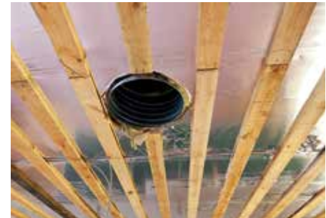
Opsætning af lavtryksventilationsanlæg og perforerede loftsplader.
