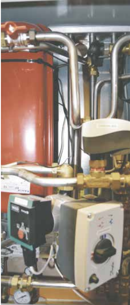
Renoveret installation til lavtemperaturfjernvarme
