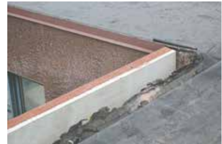
Opbygning af ny tagdækning ved nyt facadeelement.
