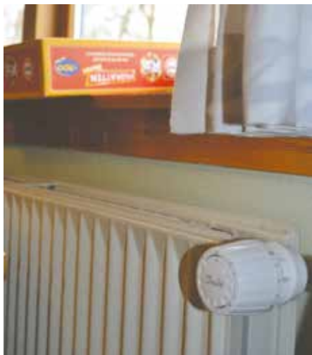
Omstilling til lavtemperatur uden udskiftning af radiator
