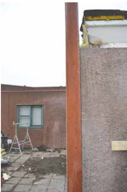
Montering af nye facadeelementer og forberedelse til tagdækning (opbygning).
