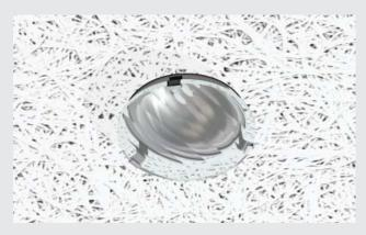
**6:** Punktstrahler, eingebaut in die Troldtekt-Decke.
