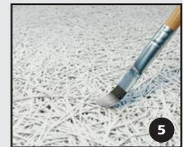
Mit Reparaturfarbe in der gleichen Farbe wie die Platte übermalen
