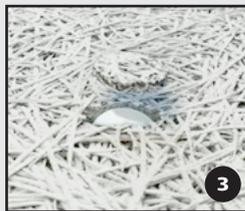
Das ausgeschnittene Stück zementgebundene Holzwolle an die Geometrie des Lochs anpassen und in das Loch einsetzen
